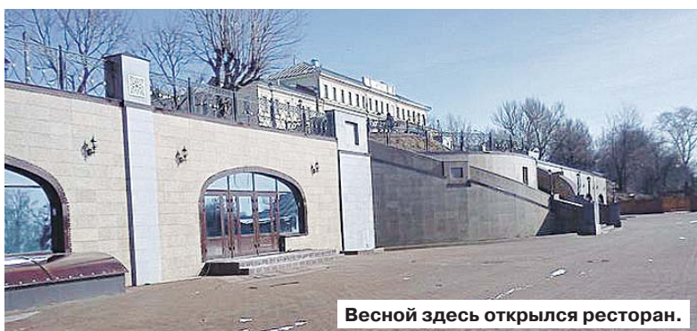
Стройка на Муравьевке.
