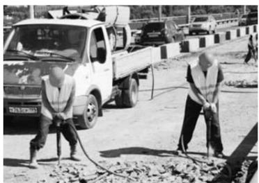
Рабочие начали устройство нового бетонного слоя. Старый асфальт сняли, разобрали деформационные швы и установили маяки. Они позволят сделать новый асфальт ровным. Также проводится ремонт опорных пролетных строений подмостового пространства.
