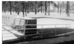
Здесь была завершена установка пандуса, выполненного в общем стилизованном решении мемориала. Снаружи он облицован полированными гранитными плитами. Внутренняя часть, предназначенная для подъема и спуска, облицована шероховатым термообработанным гранитом, чтобы предотвратить скольжение при движении по пандусу. Кроме того были установлены перила. Работы, выполненные костромскими подрядчиками, обошлись в 110 тысяч рублей и были оплачены из городского бюджета.
